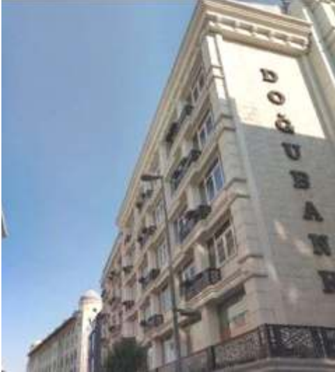
•2013 yılında Fatih Belediyesi tarafından yapılması zorunlu olan prekast cephe giydirmesi sonrasında yapının görünümü.
