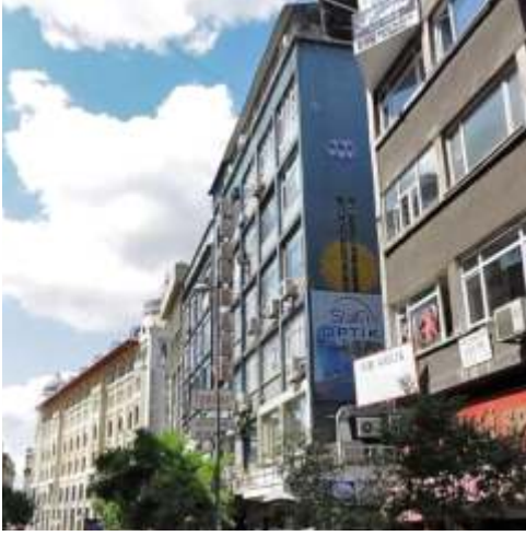
•Cephe kaplamaları yapılmadan (2013 öncesi) Doğubank Bedri Rahmi Eyüpoğlu Mozaïği
